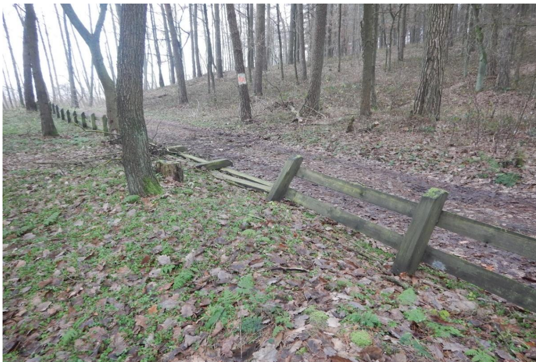
Stare ogrodzenie przy drodze leśnej (139 b)
